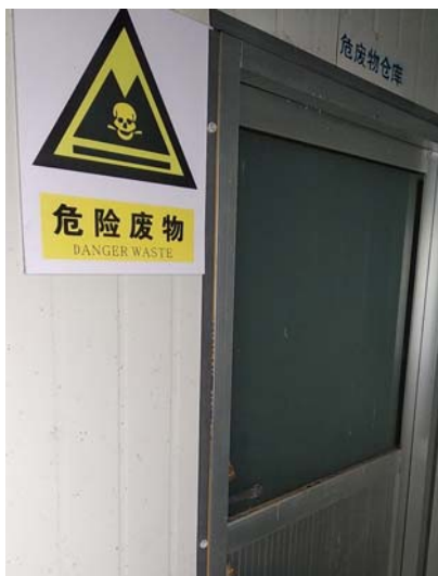
厂区危废库建设情况
